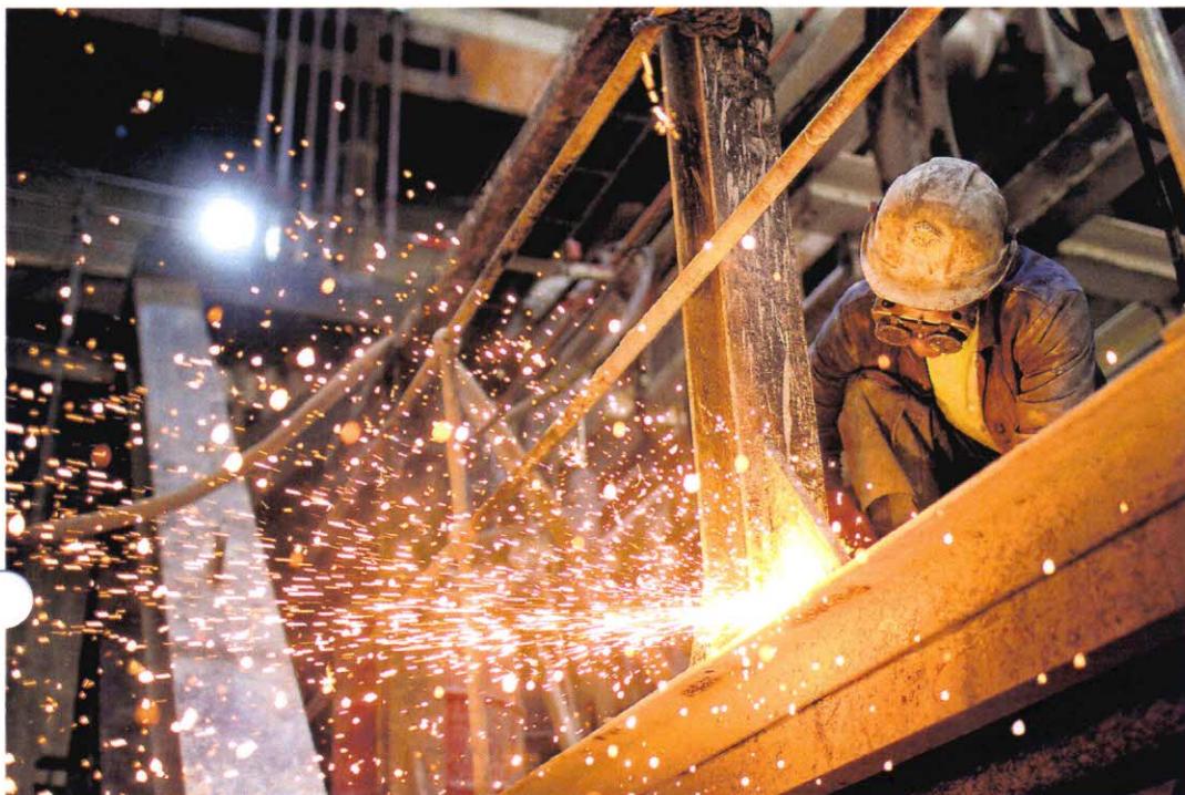
Forskere har påvist, at den danske grænseværdi for det kræftfremkaldende stof krom-6 er alt for høj. Det betyder, at mennesker, der arbejder med krom-6, risikerer at udvikle lungekræft. Krom-6 kan også forekomme i svejserøg. Fotografiet er taget ved metrobyggepladsen i Nørrebroparken og er ikke relateret til sagen. Arkivfoto: Bax Lindhardt/Ritzau Scanpix
