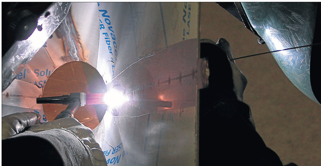
Ved svejsning i rustfrit stål frigives krom 6, og derfor er udsugning og de korrekte værnemidler nødvendige. Foto: Simon Dinsen Hansen
